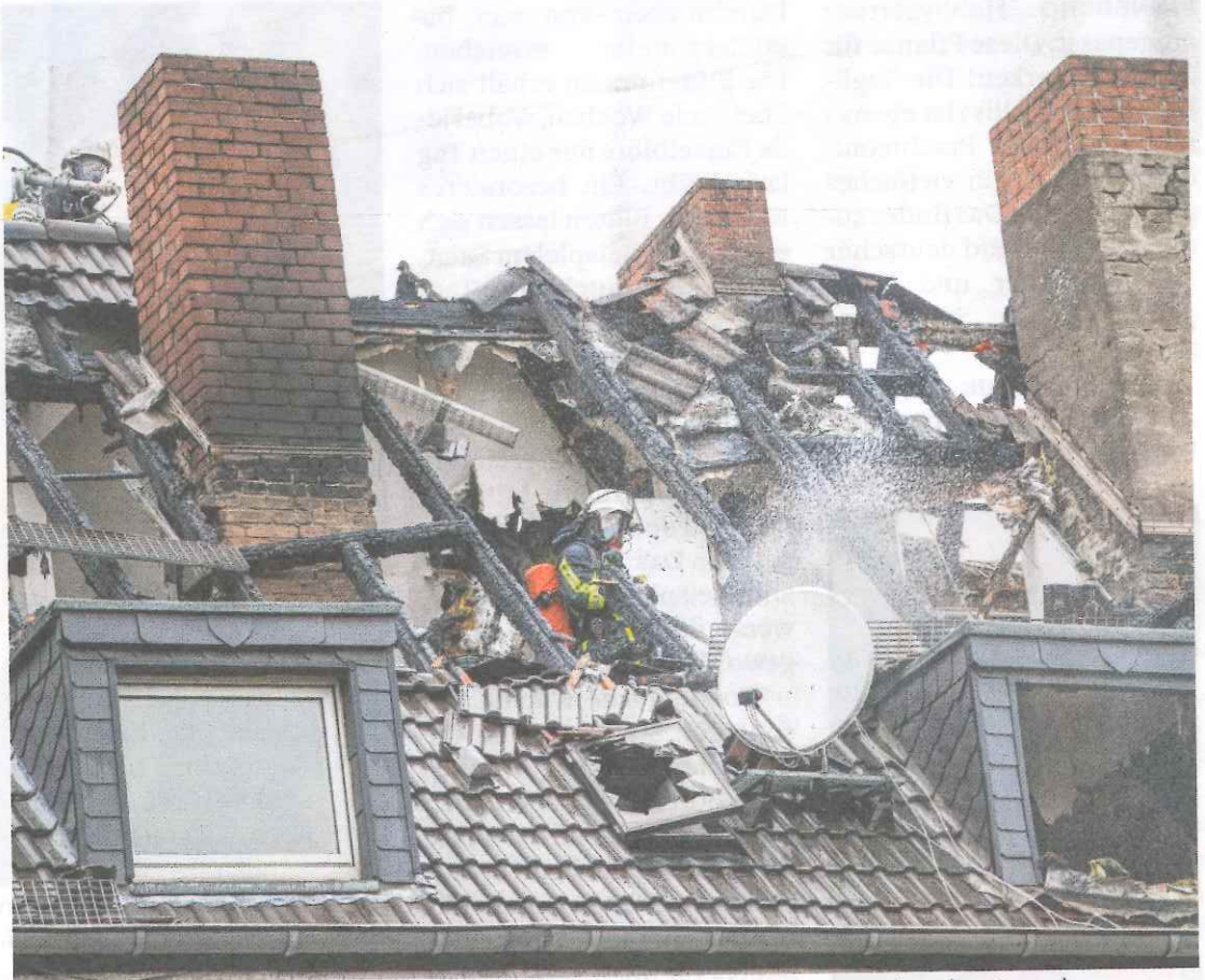
Damit es nicht so weit kommt, müssen Brandschutzschalter in Neubauten eingebaut werden. DPA
